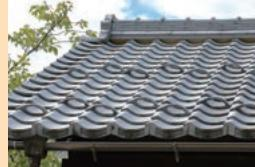
粘土を焼き固めたもので、日本建築では古くから使われている屋根材です。点検すべきポイントは、棟瓦の漆喰、ビス、瓦のずれ、割れの3つです。
