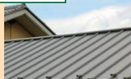
昔はトタン、現在はガルバリウム鋼板が主流になってきています。点検すべきポイントは棟板金、釘、色あせ、錆の4つになります。
