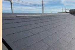
セメントが主成分の薄い板状に加工された屋根材で、住宅屋根の主流になってきています。点検する際に確認したい箇所が5つあります。
